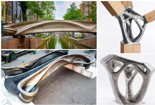
شکل 2- پل‌ها و سازه‌های واقعی ساخته توسط محققان در صنایع عمرانی توسط فرایند ساخت افزایشی قوس و سیم.
