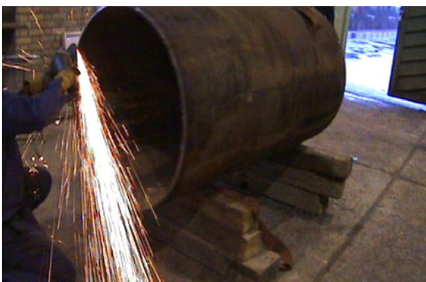
شکل ۲- آماده سازی لوله
