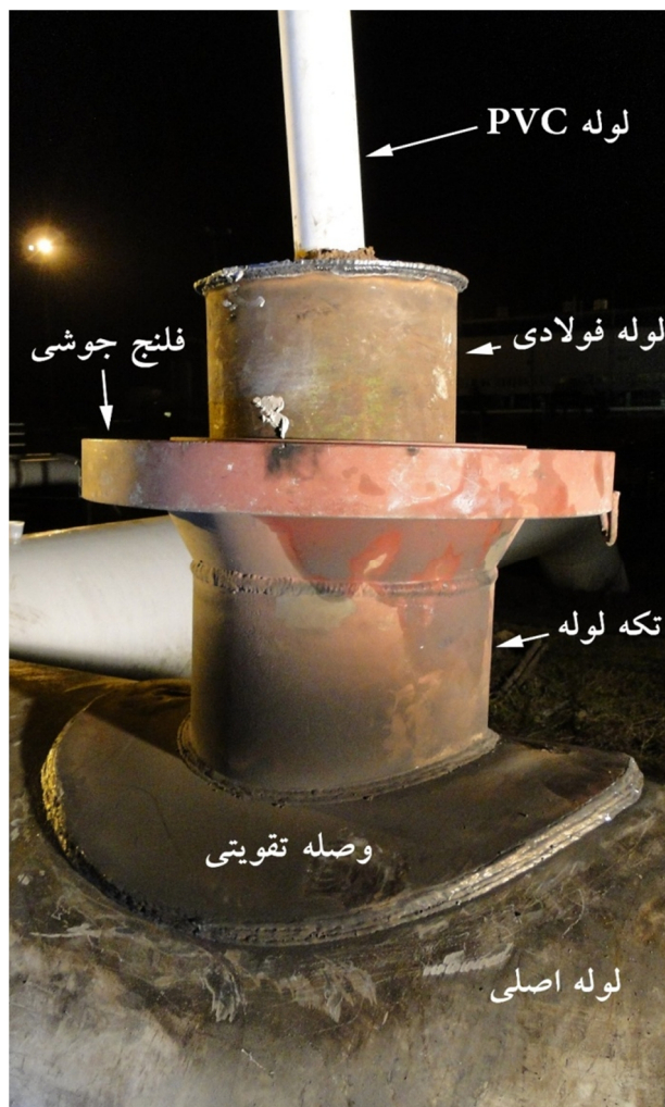
شکل 2 - تجهیزات بکاررفته در عملیات تعمیر نشتی
