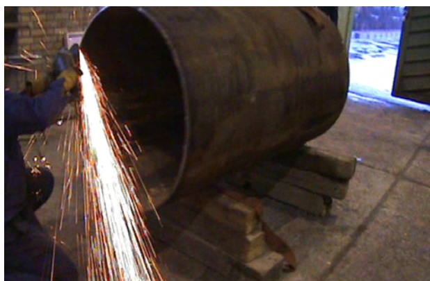
شکل ۲- آماده سازی لوله
