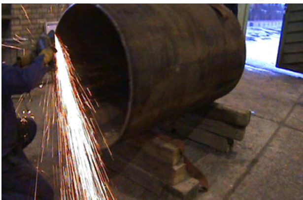
شکل ۲- آماده سازی لوله
