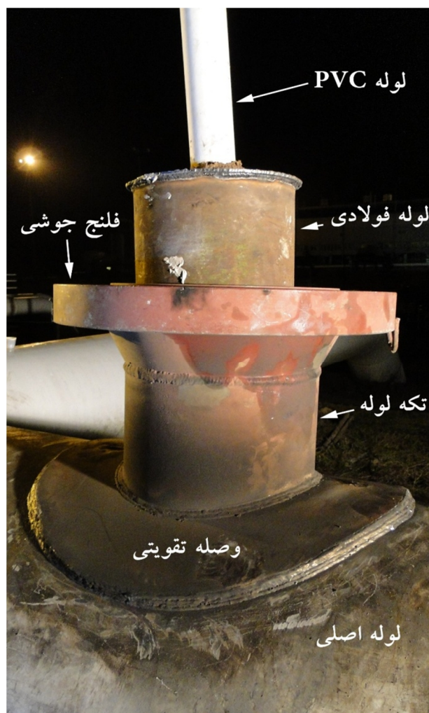
شکل 2 - تجهیزات بکاررفته در عملیات تعمیر نشتی
