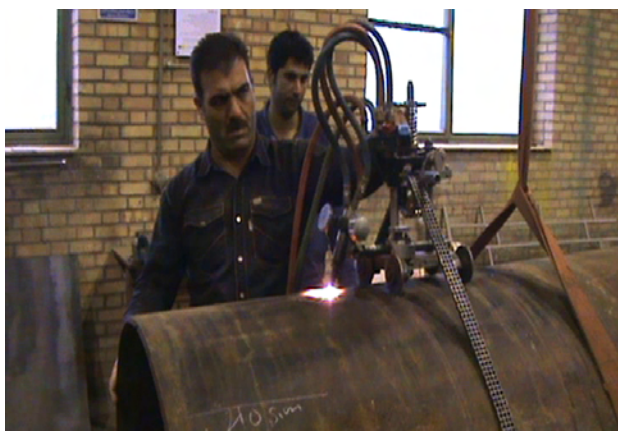
شکل ۱- برش کاری لوله
