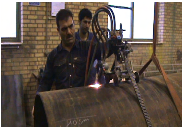
شکل ۱- برش کاری لوله
