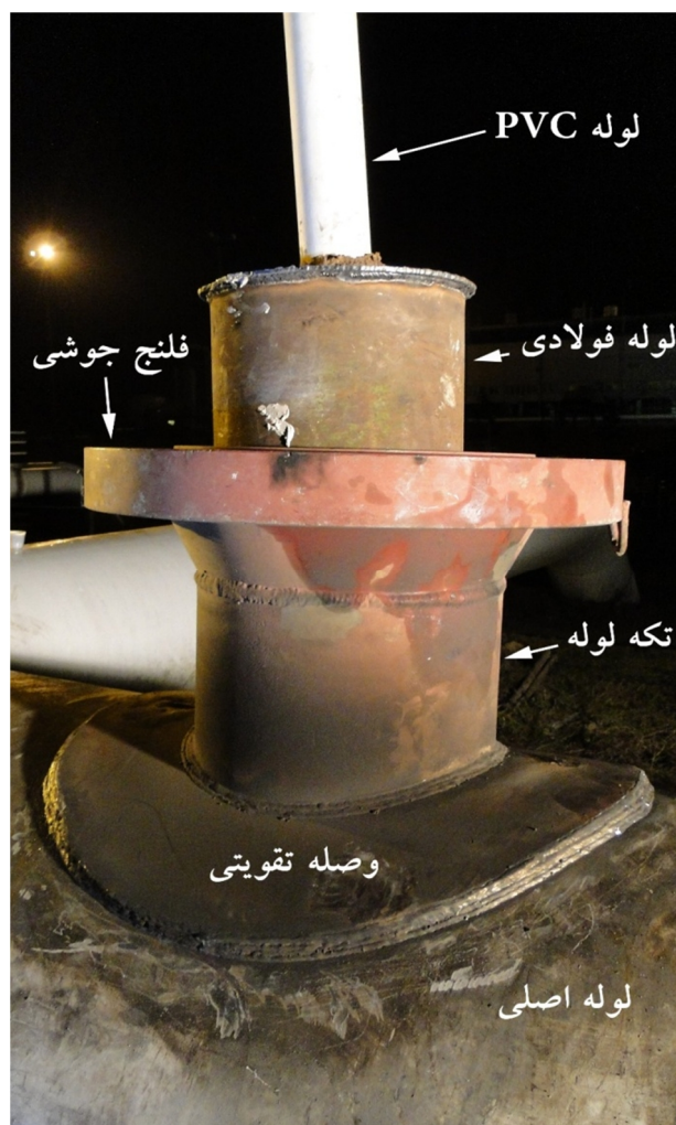
شکل 2 - تجهیزات بکاررفته در عملیات تعمیر نشتی
