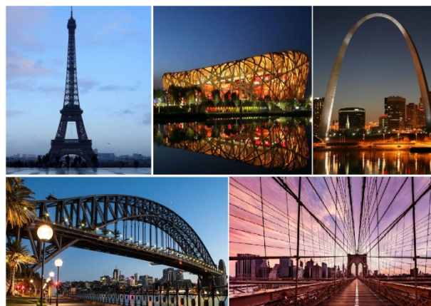
شکل 1- سازه‌ها و پل‌های تمام فلزی شناخته جهان.
