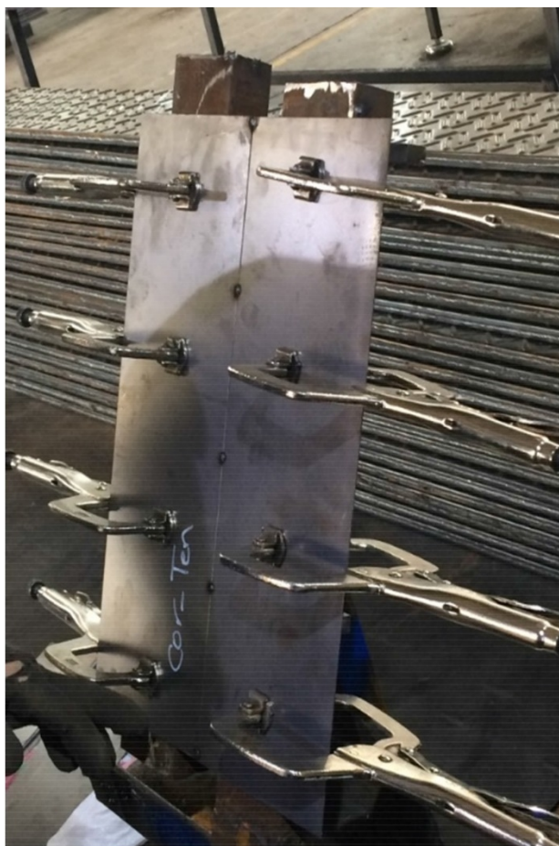
شکل 1- آماده سازی و نحوه قرارگیری ورق‌های فولادی برای جوشکاری.
