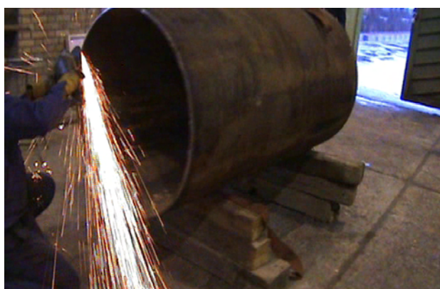
شکل ۲- آماده سازی لوله
