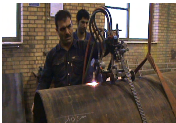
شکل ۱- برش کاری لوله
