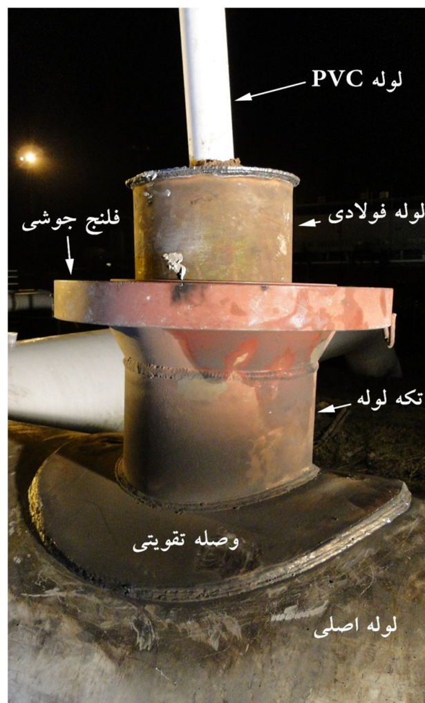
شکل 2 - تجهیزات بکاررفته در عملیات تعمیر نشتی
